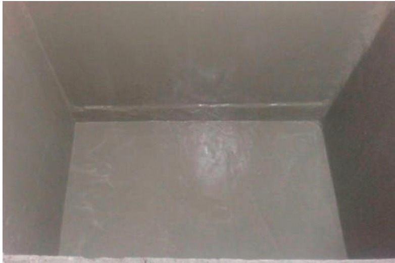
Phun thẩm thấu hố PIT thang máy
