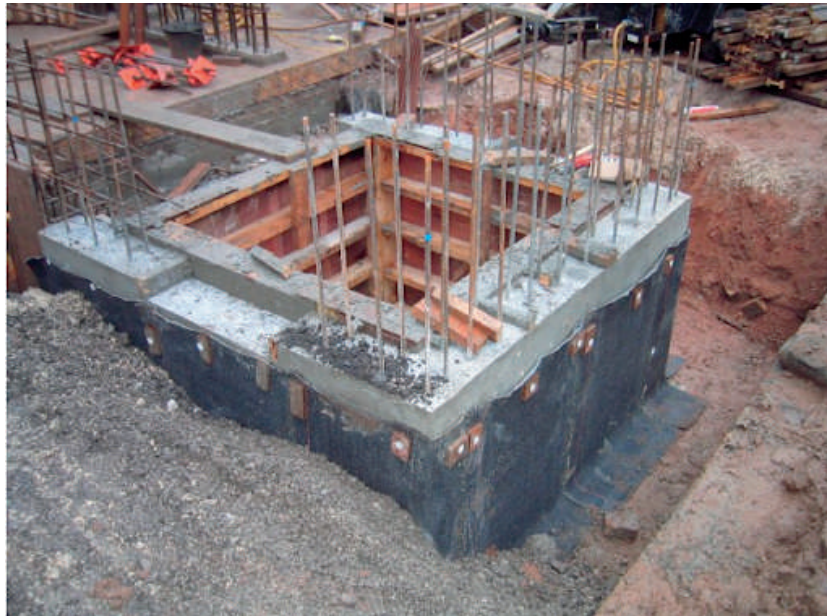
Ép cọc móng thang máy
